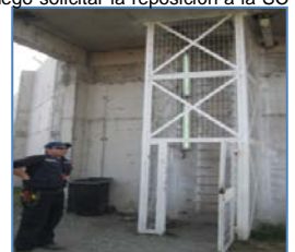
Mantenimiento Franje de Seguridad, Garitas de Vigilancia
