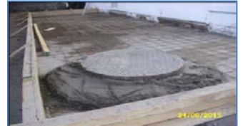
Obras de mejoramiento de pavimentos en CAI, programa de Densificación.
